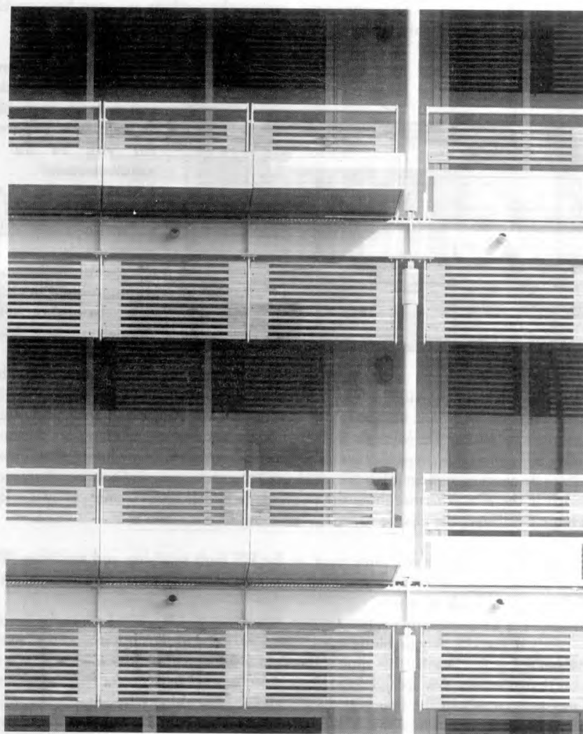
RESIDENTIAL HOTEL IN MARINA DI PIETRASANTA, 1992-96. (FURNARI). DETAIL OF LOGGIAS.
