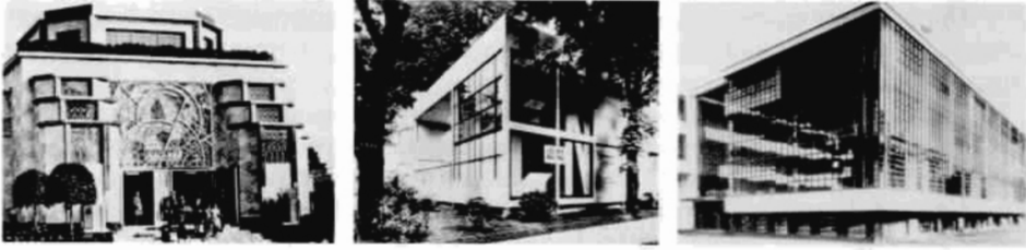
I. to r., Au Bon Marché (Department Store) Pavilion, Paris Expo, L. H. Boileau. L'Esprit Nouveau Pavilion, Paris Expo, Le Corbusier. Madime Shop, Bauhaus, Dessau, Walter Gropius.
